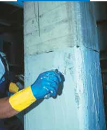
Revestimiento con MapeWrap 11 o MapeWrap 12
