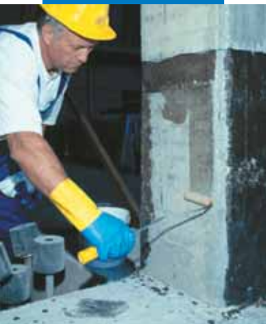
Aplicación de MapeWrap Primer 1
