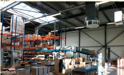
Figura 3.6: Los sistemas de ventilación adiabática proporcionan una ventilación permanente efectiva y una función de enfriamiento de costo general muy bajo.
