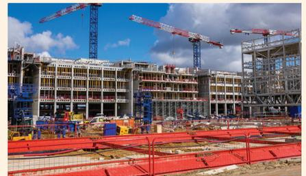
Figura 3.9 - L'ENS de Paris-Saclay en construcción. En la fachada, las hojas regulan la ventilación natural de la mayor parte de esta estructura (Renzo Piano Arquitecto).
