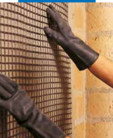
Colocación de Mapegrid G 220
