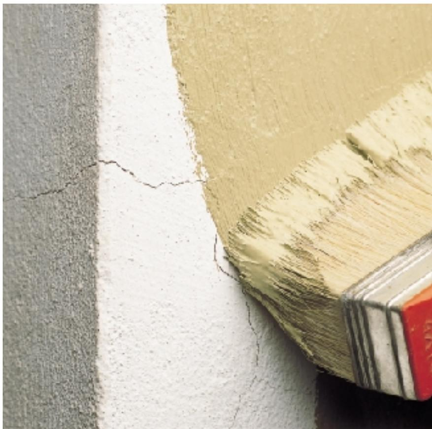
limpia y rígida y tratada preliminarmente con específico primer. Antes de proceder a la aplicación de ELASTOCOLOR PRIMER reparar eventuales zonas degradadas de hormigón con MAPEGROUT TISSOTROPICO o MAPEGROUT RAPIDO, morteros fibroreforzados con contracción controlada.
