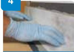
Adherir **Alsan® Velo P** (armadura) sin burbujas ni pliegues, cuando la capa está aún húmeda.
