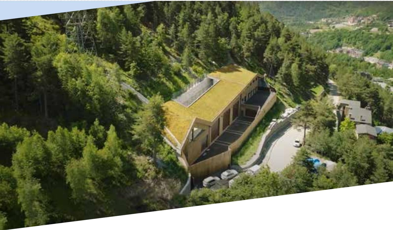
**Funcionalidad:** La cubierta ajardinada protege la impermeabilización del choque térmico y evita temperaturas extremas o fluctuantes directamente sobre ella, aumentando su vida útil. En combinación con paneles solares, ayuda a mejorar su eficiencia operativa hasta en un 25%, ya que se disminuye la emisión solar y se reduce la temperatura ambiental de la superficie.
