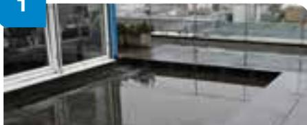
Cortar la lámina anteriormente instalada en la superficie horizontal en correspondencia con el agujero del desagüe.
