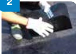
Cortar el tubo de **Draini** a la medida de fondo de desagüe insertándola en el agujero. Se doblan las alas de la banda de la cazoleta sacándolas del cartón.
