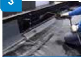
Adherir a fuego completamente la banda de terminación del sistema, hasta 20 cm por encima del acabado final de la cubierta.
