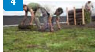
Extender manualmente los rollos de **Sopranature® Sedum MIX MAT** sobre las tierras sin solapar.
