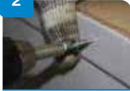
Colocar el **Perfil a pared PVC**, se fija con tacos de expansión sobre la vertical cada 25 cm, dejando la cara de PVC vista.
