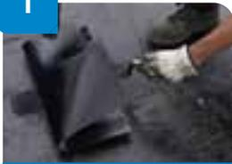
Imprimir la superficie con **Emufal Primer** o **Sopradere** a razón de 150-300 gr/m<sup>2</sup> según rugosidad y soldar refuerzo de 50x50 cm con lámina **Mortepias SBS FP 4 KG**.
