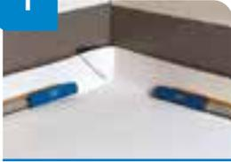
Aplicar encima de la membrana de la cubierta **Flagon® PVC** con fijaciones específicas en todo el perímetro. Se combina con el cable **Flagofil**, soldado en la membrana con aire caliente y la **Protección de la barra** de perforaciones en bordes.
