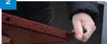
Preparación de **Sopracover Dalle**: instalación de las barras de conexión.
