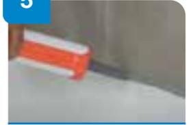
Colocar un cordón de material de sellado resistente a la intemperie tipo **Alsan® Flex 2911 CO**, en el encuentro del perfil con la pared.
