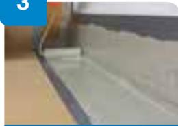
Aplicar la primera capa de **Alsan® 770 TX** ( $1,8 \text{ a } 2,5 \text{ kg/m}^2$ ) tras haber imprimado previamente según soporte.
