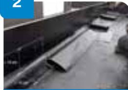
Adherir a fuego completamente la **Morterplas Band**, centrada en el cambio de sección dejando al menos 15 cm en cada faldón.
