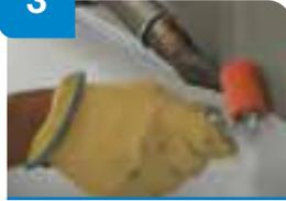
El remate vertical con membrana **Flagon® PVC** se suelda mediante pistola de aire caliente sobre toda la longitud del perfil acoplado a PVC.
