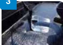
Adherir **Draini** al soporte y con la ayuda de un paletín ir desdoblado y colocando la banda. Se aplica fuego hasta obtener una rebaba para sellar con el paletín.
