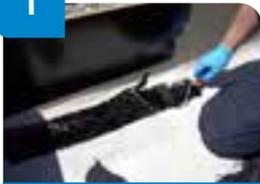
Imprimir la superficie con **Emufal Primer** o **Sopradere®** a razón de ≈150-300 gr/m<sup>2</sup> según rugosidad y material.
