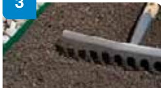
Colocar perfiles en los límites o limitar la zona vegetal. Extender **Sopraflor Extensivo** en toda la cubierta 7 a 10 cm.
