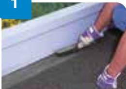
Remover la pizarilla suelta de las láminas existentes con un cepillo metálico.
