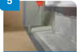
Aplicar la segunda capa de **Alsan® 770 TX** ( $1 \text{ a } 2 \text{ kg/m}^2$ ).
