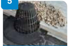
Colocar apoyado sobre la impermeabilización el **Paragravillas sombrero** y aplicar el resto de capas de la cubierta lastrada.
