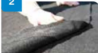
Solapar rollos de **Drentex Impact Garden** encajando los nódulos y sobreponiendo el geotextil superior negro.
