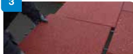
Colocar **Sopracover Dalle** a rompejuntas directamente sobre la impermeabilización.
