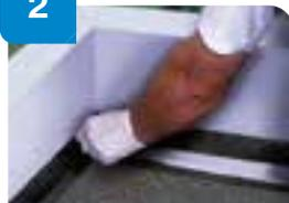
Adherir **Textil** (armadura) con **Textop** (500 gr/m<sup>2</sup>).
