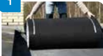
Posicionar y desenrollar el drenaje **Drentex Impact Garden** sobre el soporte.
