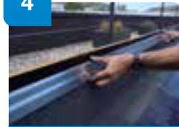
Colocar el **Perfil metálico**, mediante elementos de fijación anclados a la pared cada 25 cm solapándose 4 cm, como mínimo, sobre la banda de terminación.
